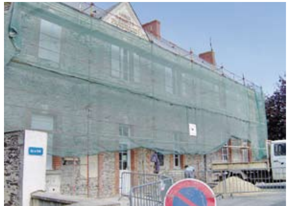
Réfection de la façade de la Mairie
